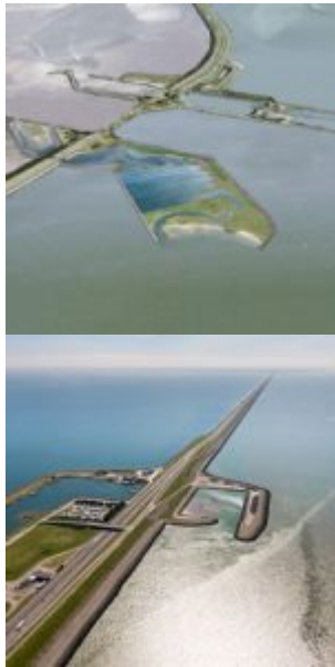
Luchtfotografie Nederland, mei 2014, Friesland. De afsluitdijk te hoogte van de Zuiderhaven. Het blauwe gebouw is de Blue Energy Proefinstallatie. Foto: Ivo Vrancken
